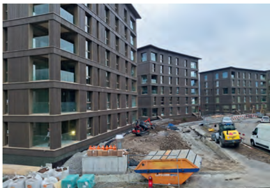
Umgebungsarbeiten bei den Mehrfamilienhäuser Allmendweg 10, 8 und 6 (v.l.n.r.)
