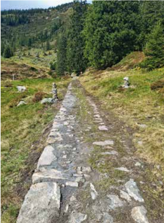
Sanierte Teilstücke an der «Tremola en miniature»
