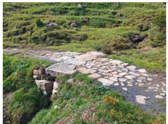
Sanierte Teilstücke an der «Tremola en miniature»
