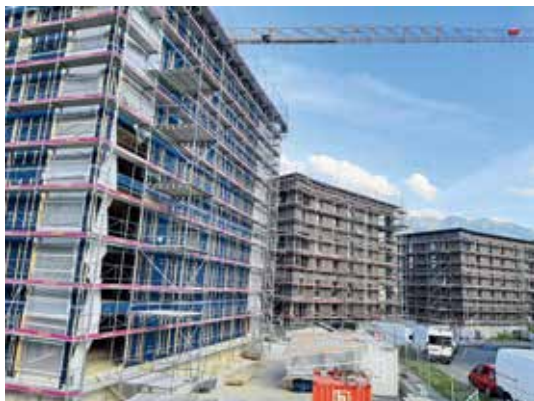
Aktueller Stand der Bauarbeiten Mehrfamilienhäuser Allmendweg 6, 8 und 10
