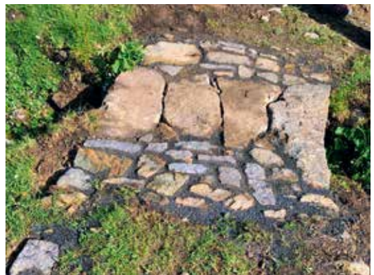
Sanierungsarbeiten an der «Tremola en miniature»
